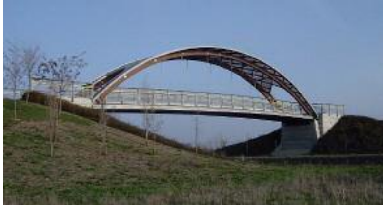
Photo 1 : passerelle de Blagnac mettant en œuvre le bois ( Photo DDE 31 )
