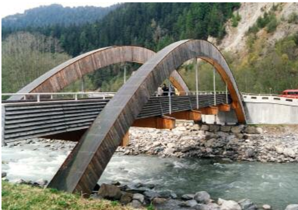
Photo 5 : pont de Scuols (Suisse) en arc bardé avec du mélèze
